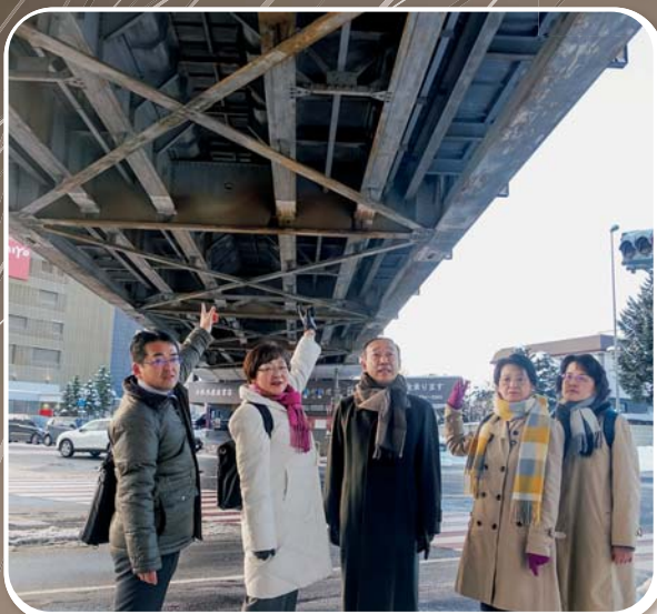
JR新札幌駅近くの高架橋を調査する道議団
